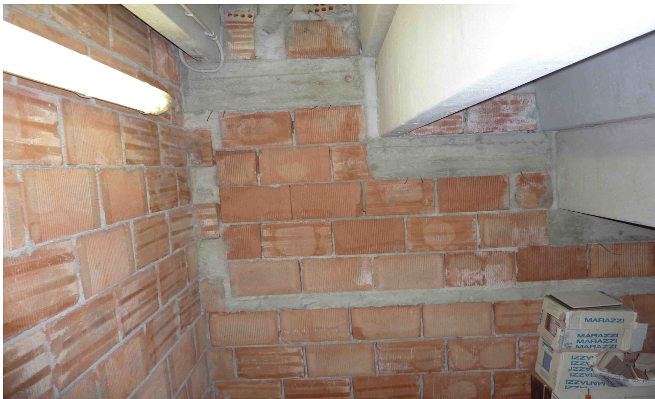
FOTO N. 6 – VISTA PARTICOLARE DEGLI APPOGGI DEI TEGOLI PREFABBRICATI SU MURATURA TIPO "POROTON" (SOTTOSTANTI LE GRADINATE DI CUI ALLA VISTA 5) CON INTERPOSTO CORDOLO IN C.C.A. A CUI ANCORARE LE STAFFE.
