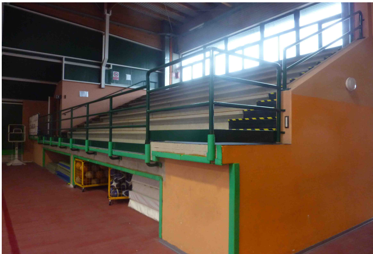
FOTO N. 5 – VISTA DI GRADINATA REALIZZATA IN TEGOLI PREFABBRICATI DA SOLIDARIZZARE AGLI APPOGGI CON STAFFATURA AD L IN ACCIAIO.
