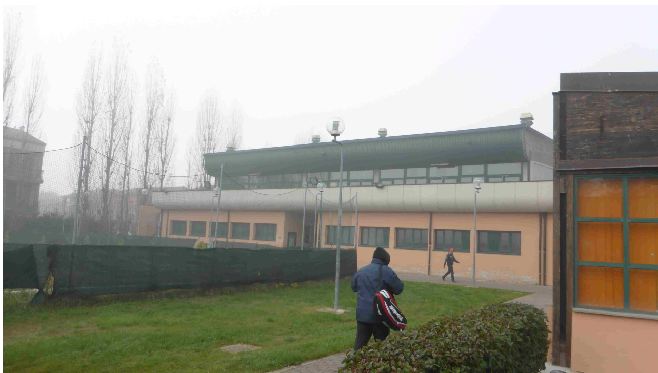
FOTO N. 1 – VISTA FRONTALE DEL PALAZZETTO, LA PARETE FINESTRATA A PIANO TERRA E' FRA LE STRUTTURE MURARIE DA CONSOLIDARE
