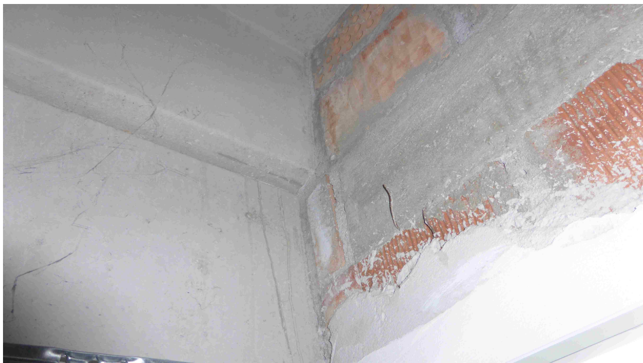
FOTO N. 13 -14 – VISTE DELL'INTERCAPEDINE TRA CONTROSOFFITTATURA E INTRADOSSO GRADINATE.
