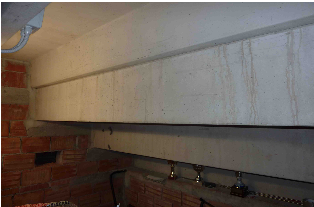
FOTO N. 7-8 – VISTA PARTICOLARE DEGLI APPOGGI DEI TEGOLI PREFABBRICATI SU MURATURA TIPO “POROTON” (SOTTOSTANTI LE GRADINATE DI CUI ALLA VISTA 5) CON INTERPOSTO CORDOLO IN C.C.A. A CUI ANCORARE LE STAFFE.
